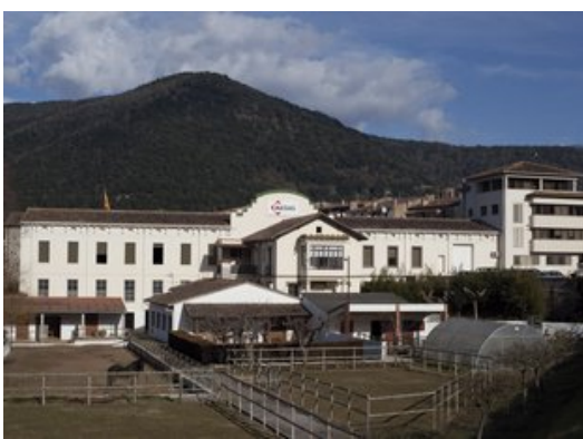
Exterior de l'empresa Masias Recycling, a Sant Joan les Fonts, especialitzada en plantes i serveis per al tractament de residus urbans. Foto: EL PUNT AVUI.
