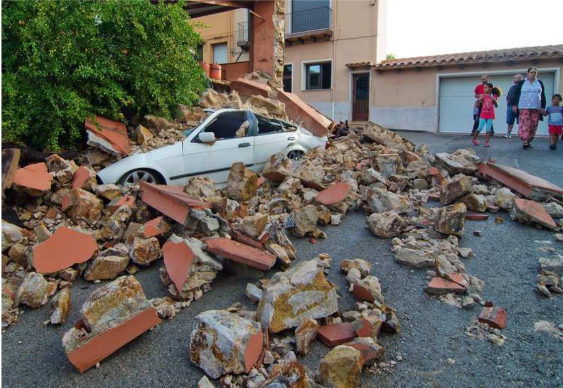
Un mur de contenció es va esfondrar i va caure al damunt de dos cotxes al carrer Sobrevia, a Sant Feliu de Guíxols. Foto: ENRIC ESTARLÍ.
