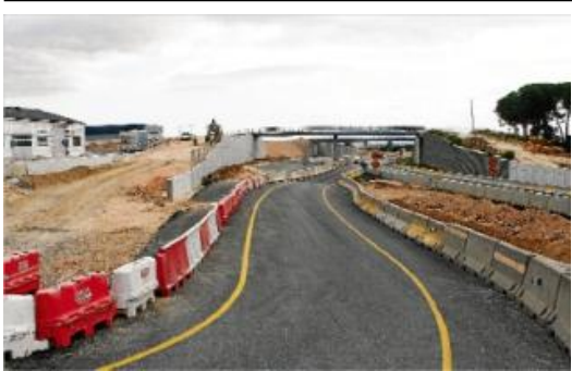
Les obres de desdoblament entre Sils i Caldes avancen, però ja van tard.
