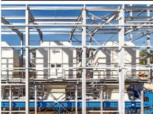
Les instal·lacions de l'empresa a Sant Joan les Fonts.
