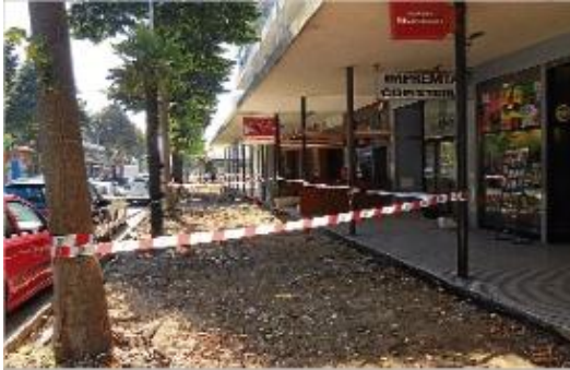
Les obres de reurbanització de l'Eurocenter.
