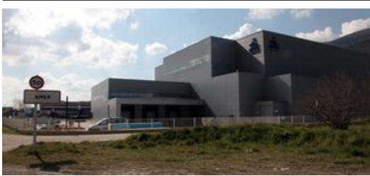
Una imatge de la seu central d'Hipra a Amer, fa uns dies. Les instal·lacions s'amplien amb una parcel·la de 6.500 metres quadrats Foto: JOAN SABATER.
