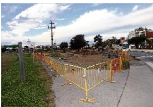
Les obres que han començat aquesta setmana.
