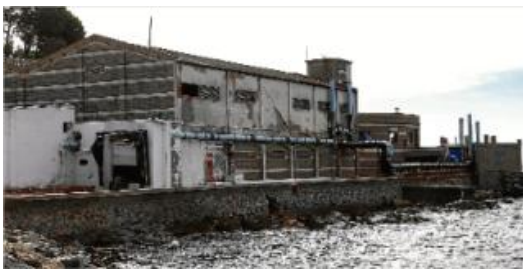
Les instal·lacions de la depuradora de marisc en desús i a l'espera que s'enderroquin.
