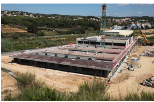
Les obres de l'escola Sa Forcadera de Blanes, que està a mig fer, en una imatge del setembre passat Foto: JOAN SABATER.
