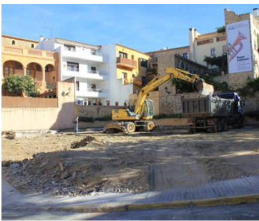
Els treballs de reforma de la central plaça d'Esteve i Cruañas, a Begur Foto: EL PUNT AVUI.
