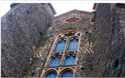
Part de darrere de l'església amb finestres, on preveuen posar-hi vitralls.
