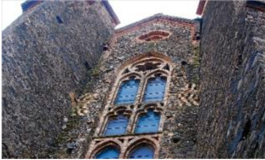
Part de darrere de l'església amb finestres, on preveuen posar-hi vitralls.
