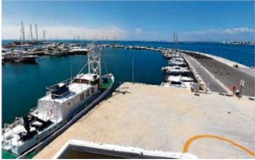
Les instal·lacions del port esportiu, a la banda esquerra amb la zona de llevant on s'actuarà.
