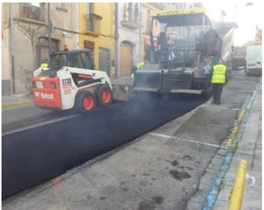
Les obres al carrer Sant Jaume, que ja s'han acabat. Foto: EL PUNT AVUI.
