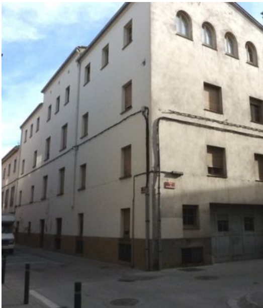
L'edifici destinat a ser la nova seu de la biblioteca pública de Banyoles. Foto: R. E.
