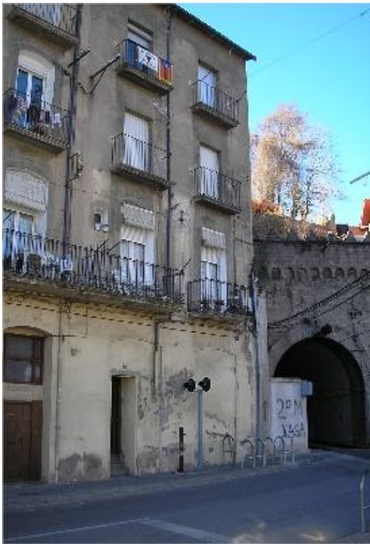
Les flames es van originar en el primer pis de l'edifici del passeig Ragull.
