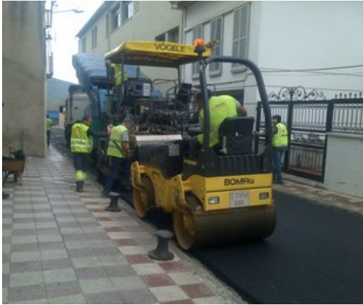
Un dels carrers que s'han asfaltat, en una imatge d'abans de les festes de Nadal. Foto: EL PUNT AVUI.
