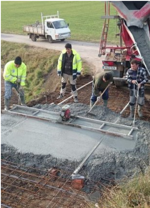
Les obres. Foto: J.C.
