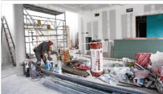
Imatge de l'interior de la llar d'infants, ahir, on els treballadors de la constructoria seguien treballant.
