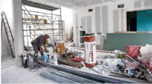
Imatge de l'interior de la llar d'infants, ahir, on els treballadors de la constructoria seguien treballant.
