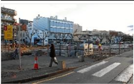
Les obres que s'han portat a terme a la Rambla Ginjolars.
