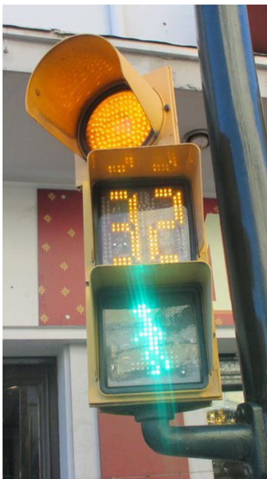
Un dels semàfors , instal·lats Foto: EL PUNT AVUI.
