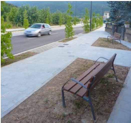
Un dels carrers de la urbanització Pla de Bastons, pocs dies després de la finalització de les obres. Foto: R. E.
