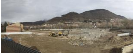
Visió panoràmica de les obres que s'estan fent a l'antiga fàbrica de La Preparación Textil, on ha d'anar ubicat el Mercadona Foto: Jordi Puig.
