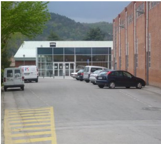
Una vista de la façana de la piscina municipal de Ripoll, on ara s'inicien les obres de millora del seu vas principal. Foto: J.C.
