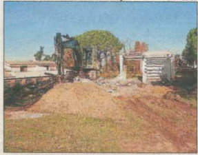
Un màquina treballa en l'enderroc.
