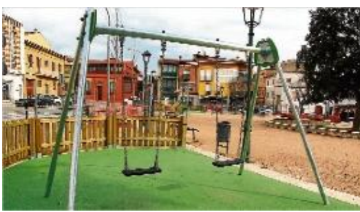
La plaça del Firal de Santa Coloma de Farners, actualment en obres.
