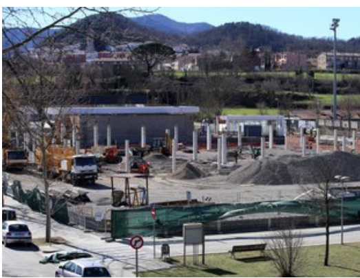
Inici de les obres del Mercadona a l'antiga fàbrica de Can Domènech, a Olot. Foto: MANEL LLADÓ.
