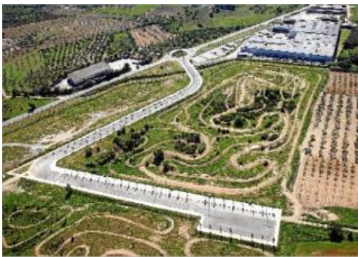
La zona industrial de Roses que es va començar a projectar el 1998.
