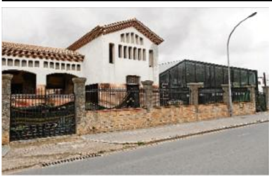
Part de l'antic escorxador, amb la Biblioteca Comarcal al costat.
