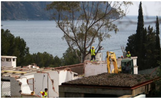
Els operaris segueixen desmuntant les instal·lacions de cala Montjoi Foto: MANEL LLADÓ.
