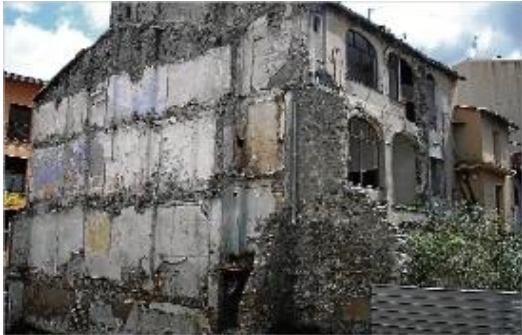
El nou carrer està ubicat a l'altura de la plaça Caprànica.
