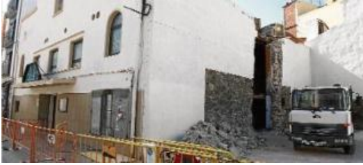
Els treballs d'enderroc que han començat a l'edifici de la SUF de Roses.
