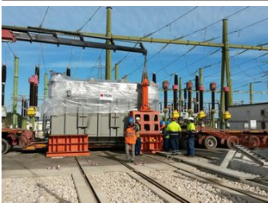
Un moment del procés d'instal·lació del nou transformador Foto: EL PUNT AVUI.
