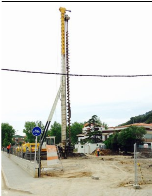
Els fonaments de la llar d'infants ja s'estan preperant amb una perforadora de grans dimensions. Foto: J. PUNTÍ.
