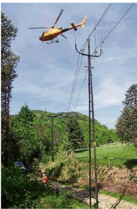
L'helicòpter posa la torre nova sobre la base de ciment.
