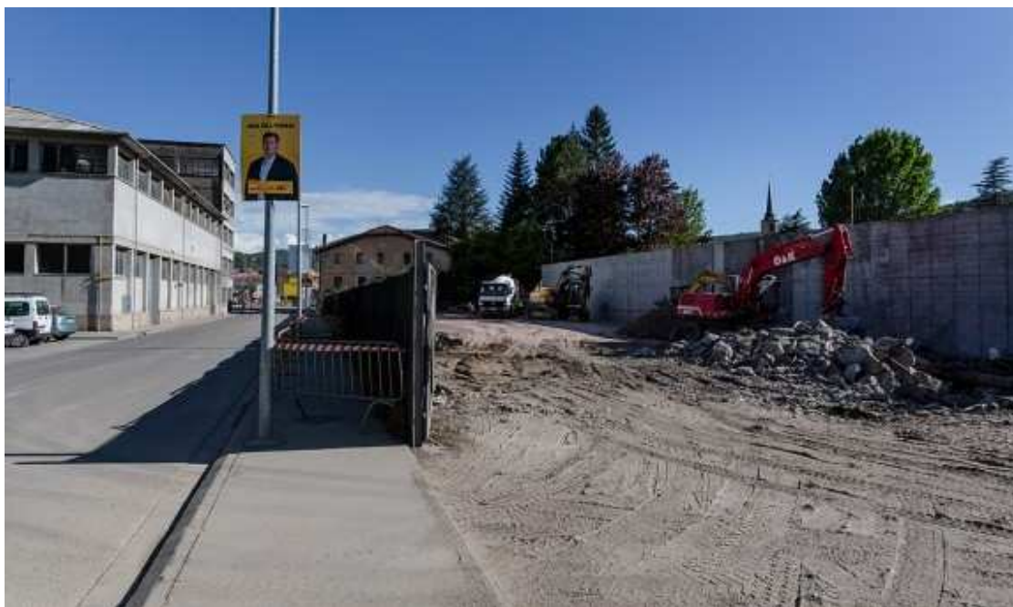
Obres de construcció del mur de construcció a la futura premsa de Comforsa. Foto: Adrià Costa
