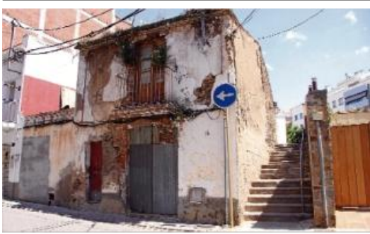
La finca del carrer Trinitat, que ha adquirit l'Ajuntament de Roses i que s'enderrocarà.
