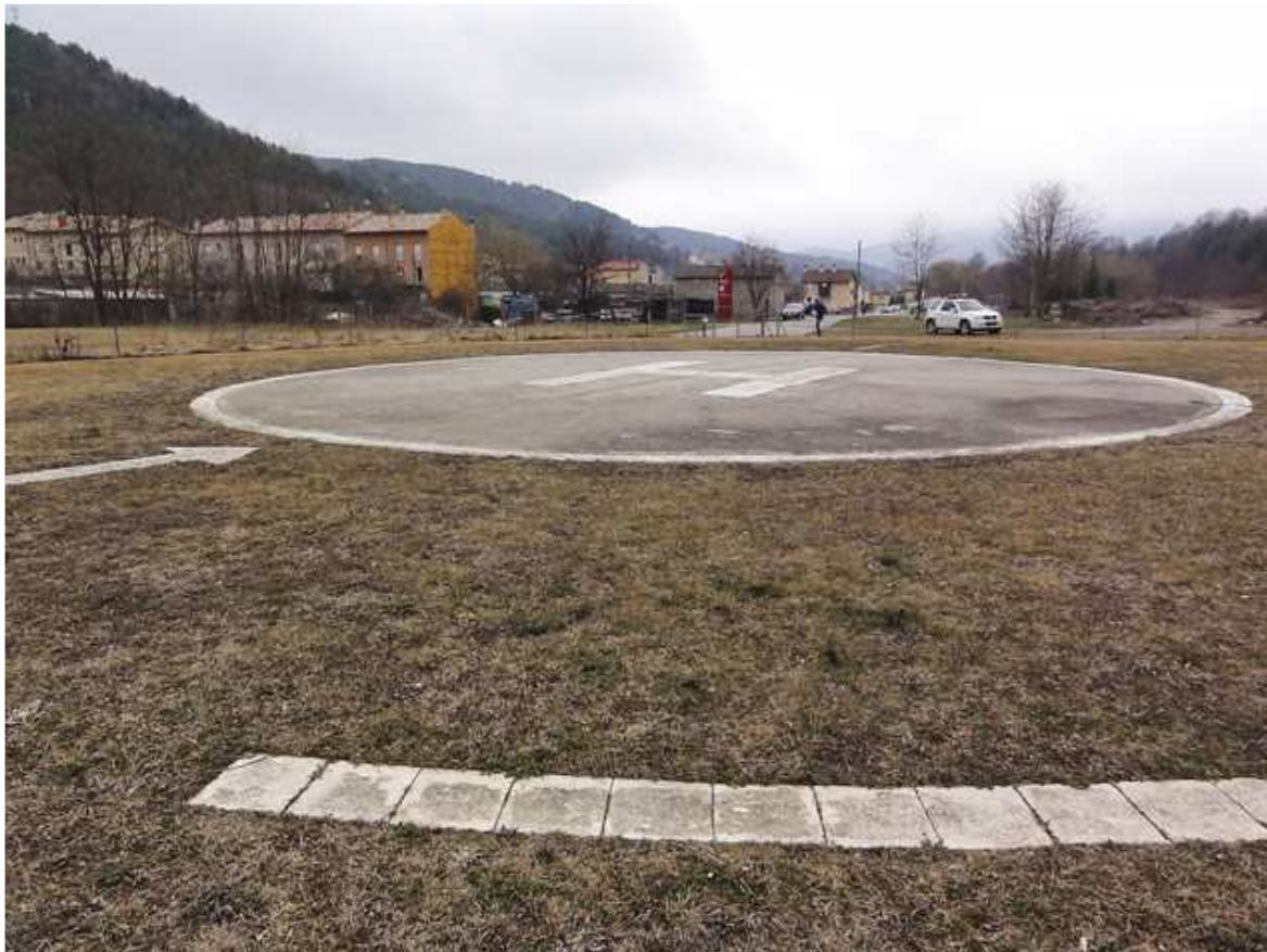
Estat actual de l'heliport de Campdevàrol, que és el de referència de l'hospital comarcal
