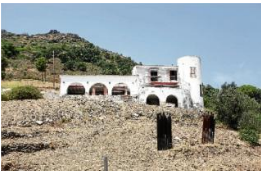
Adrià acaba les obres de la primera fase d'El Bulli, 1846
