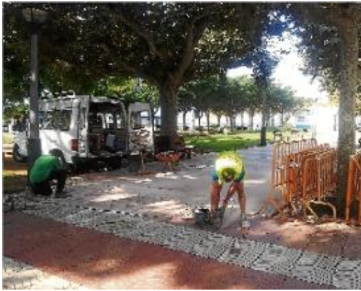
Uns operaris treballant en la substitució.
