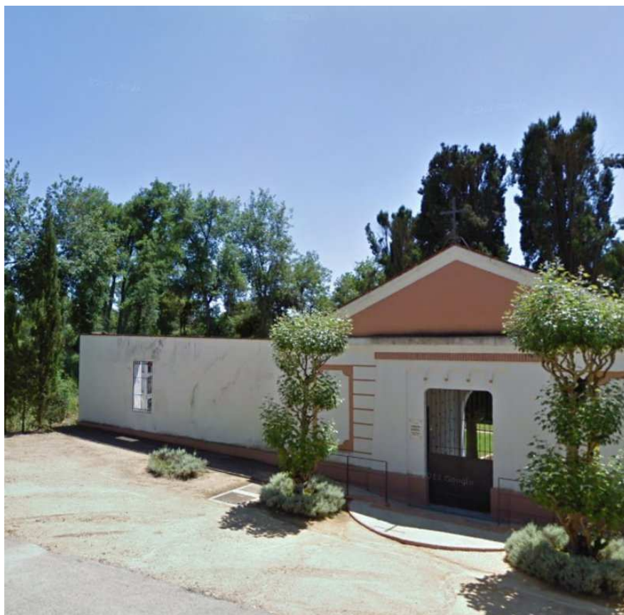
El cementiri de Caldes, i els terrenys on es construiria el tanatori, que estan a l'esquerra de l'edificació. Foto: EL PUNT AVUI.
