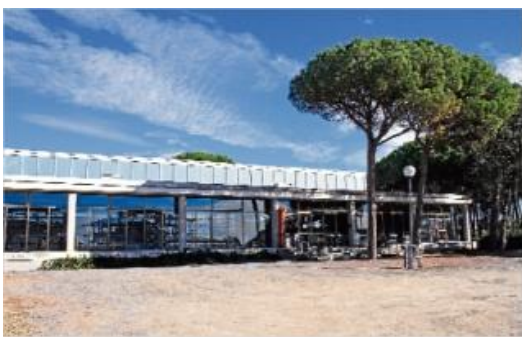
Imatge actual del pavelló poliesportiu municipal de Riudellots de la Selva, que s'ampliarà en l'extrem oest.
