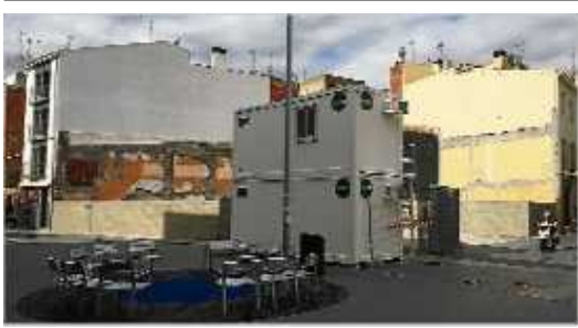
El solar després d'enderrocar-se l'edifici.
