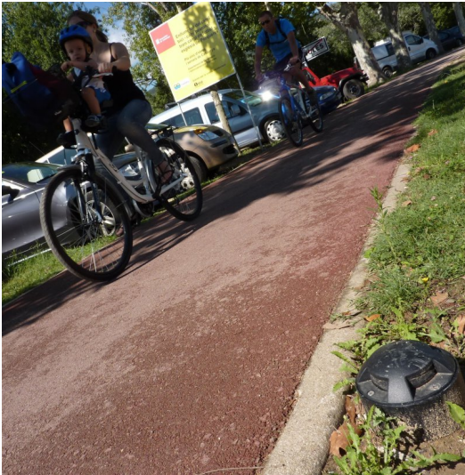
Detall del carril bici de l'estany, en una imatge d'arxiu. Foto: R. E..
