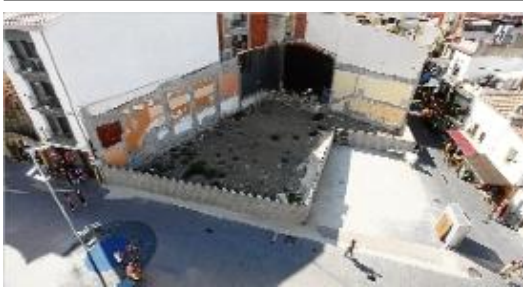
Les obres per construir el nou edifici sobre l'antic solar de la SUF.
