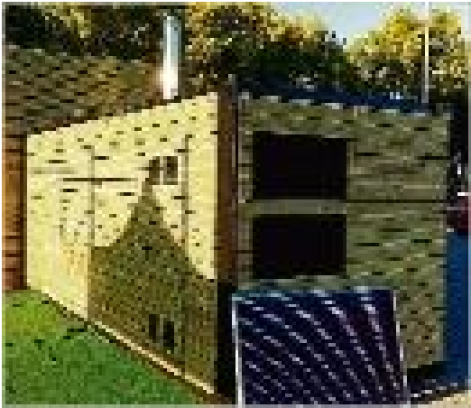
La instal·lació de Roses.
