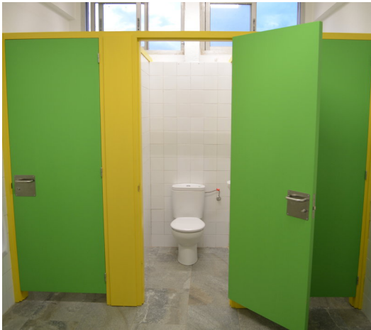
Una de les actuacions per aquest nou curs ha estat la reforma dels lavabos dels nens Foto: EL PUNT AVUI.
