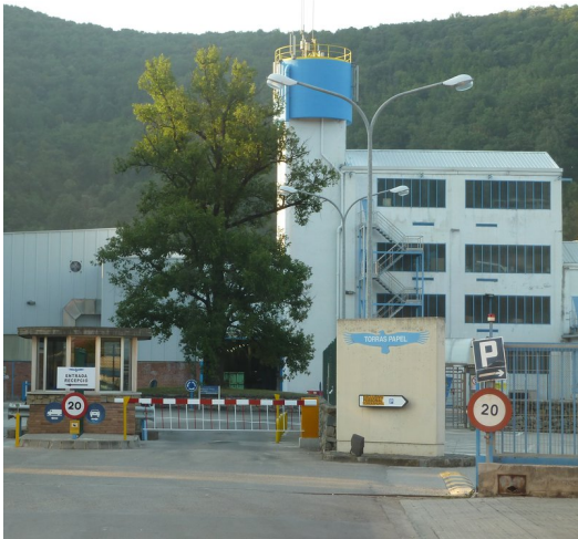
Exteriors de l'empresa de Torraspapel Foto: JORDI CASAS.
