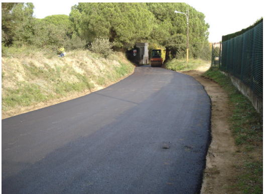
Els treballs d'asfaltatge realitzats divendres en un tram del carrer de Roqueta, al sector de Sant Joan de Palamós Foto: EL PUNT AVUI.
